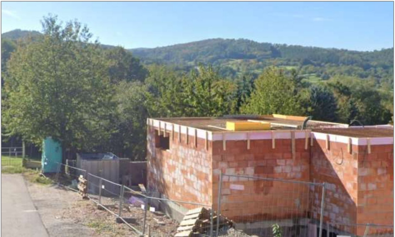
Foto 29: Ein Beispiel dafür wie trotz Bebauung ein Teil der Streuobstbäume auf dem Baugrundstück (im Hintergrund hinter dem Rohbau) erhalten bleiben kann (Rohrbach)
